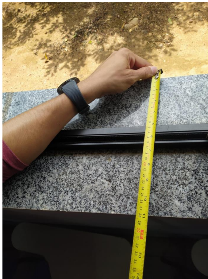
Imagem 01 – Existência de peitoris com 27,5 cm de largura no Bloco B do Câmpus Paraíso.
